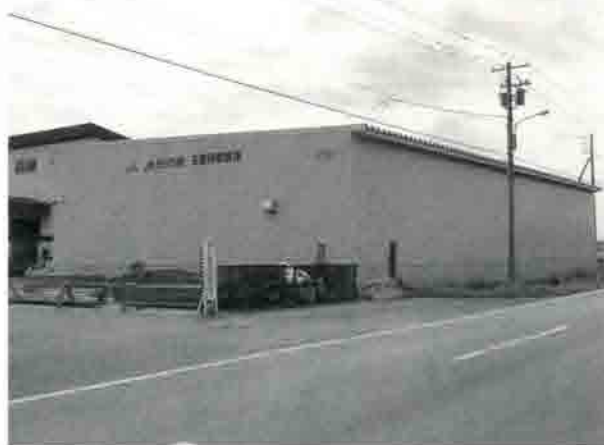
玉葱保管倉庫の新築工事が終了しました。竣工式の模様は10月号でお伝えいたします。
