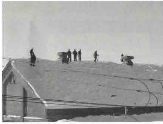
倉庫屋根の除雪作業
